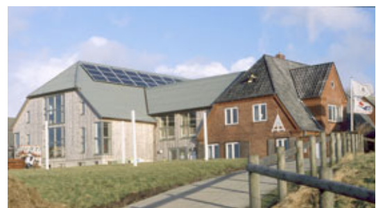
Das Wattenmeerhaus auf Hallig Hoog – Ein Demonstrationsobjekt für die Nutzung regenerativer Energien
