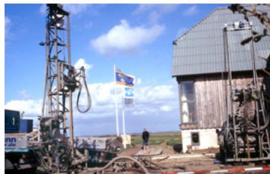
Bis in 110 m Tiefe gingen die Bohrungen für die Sole-Wasser-Wärmepumpe
